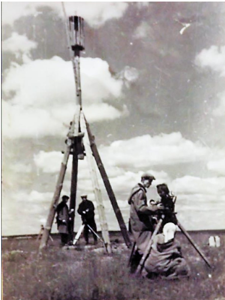
Проведение топографической съемки изыскательской экспедиции «Гипрокаучук» на площадке химкомбината
